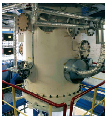
Figure 10. Réacteur microstructuré du projet DEMIS porté par Degussa
